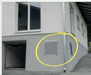
Aufstellung in einer Garage: Innen geringer Platzbedarf, und von außen so gut wie unsichtbar - nur die beiden Wetterschutzgitter zeigen die Position der Wärmepumpe an.
